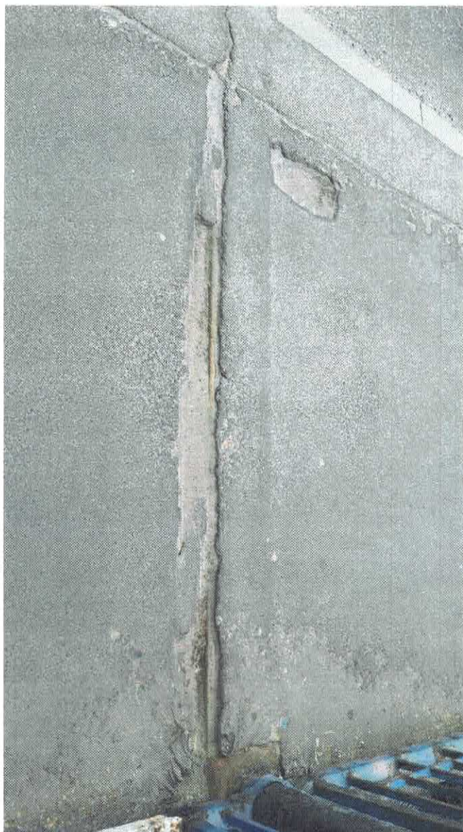
Fot.3. Rysy, deformacje, ubytki nawierzchni w obrębie dylatacji
