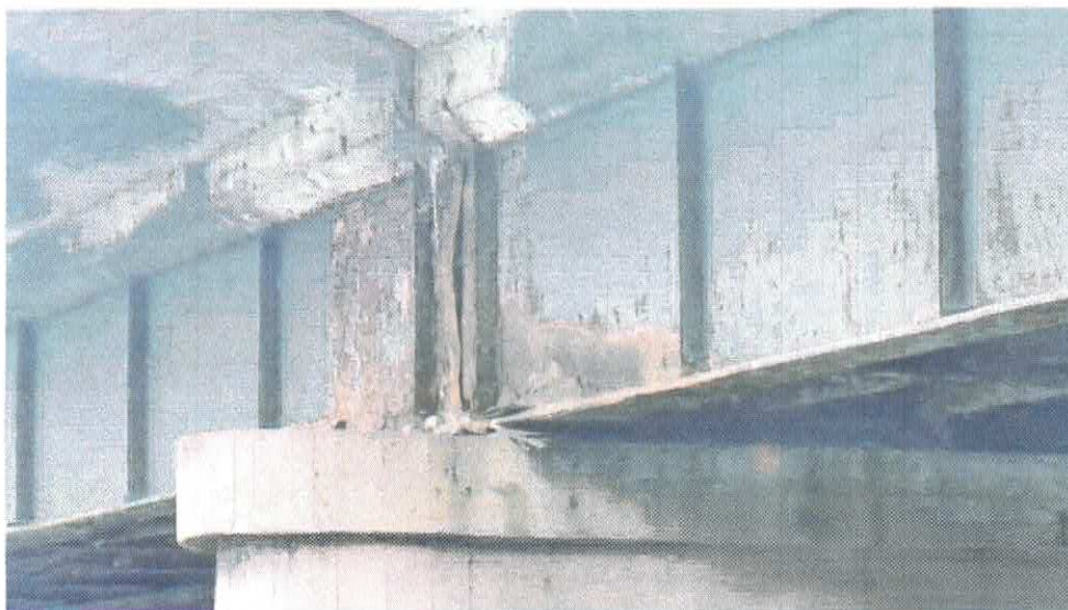
Fot.4. korozja belek nośnych, deformacje belek środkika nośnych, przecieki płyty pomostowej w obrębie dylatacji
