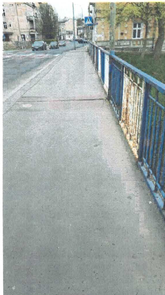
Fot.1 Rysy, deformacje, ubytki nawierzchni w obrębie dylatacji
