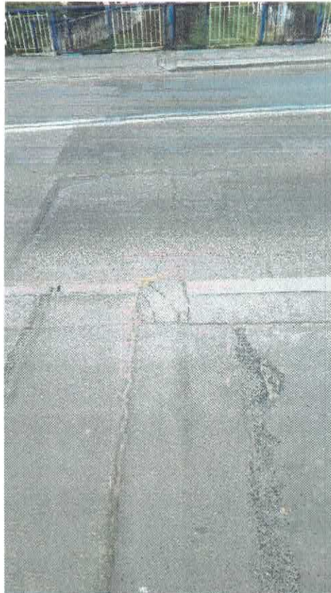
Fot.1 Rysy, deformacje, ubytki nawierzchni w obrębie dylatacji
